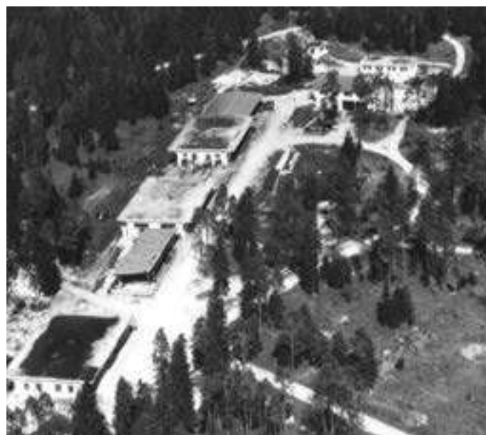
Abb. 12: Zustand der Hallen vor dem Erwerb 1949 (aus [3])
