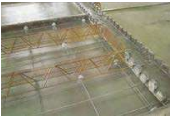
Abb. 52: Streckmetall als Schalung (aus [36])
