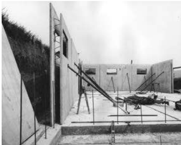
Abb. 57: Aufgestellte FILIGRAN-Wandelemente (aus S4-F2-M9)
