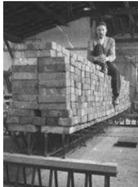
Abb. 3: Stefan Keller bei einem der ersten Versuche am FILIGRAN-Fachwerkträger bei Metallbau Semler ca. 1947 (aus S1-F2-M11)
