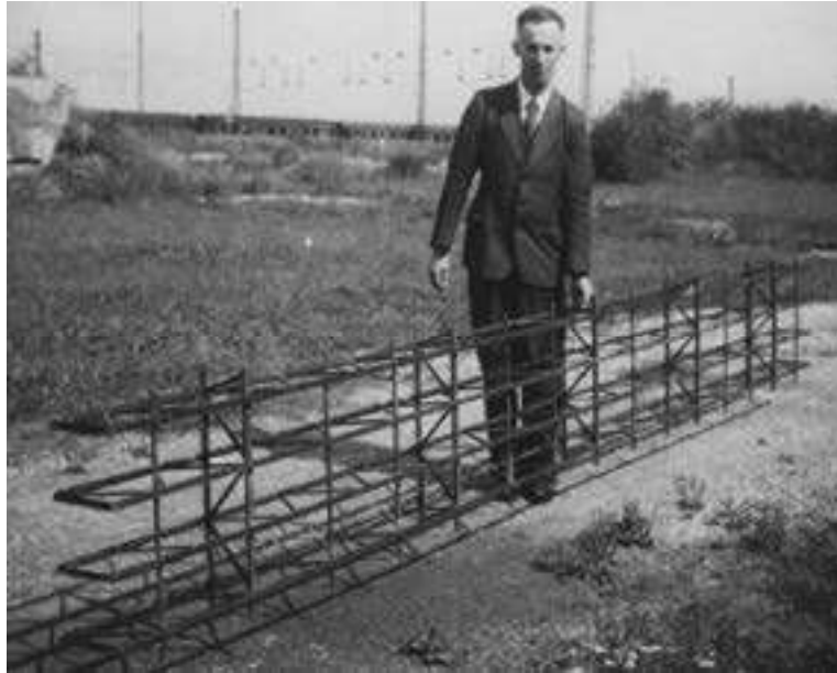
Abb. 22: Einzelelement für FILIGRAN-Gitterdecke (aus S1-F2-M11)
