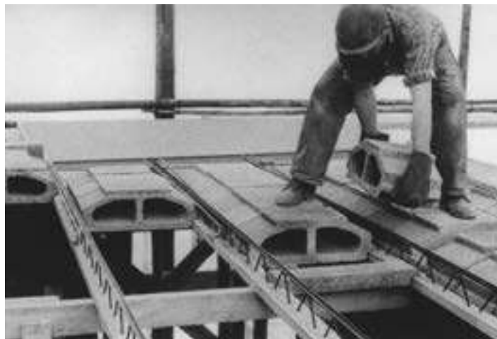
Abb. 40: FILIGRAN-Standarddecke (aus S1-F2-M11)
