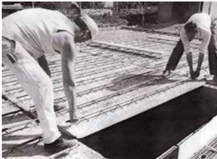
Abb. 46: Verlegen der FILIGRAN-Streifen-Elemente auf der Baustelle (aus [23])
