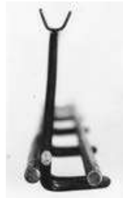
Abb. 25: Querschnitt eines SK-Trägers (aus S4-F3-M7)
