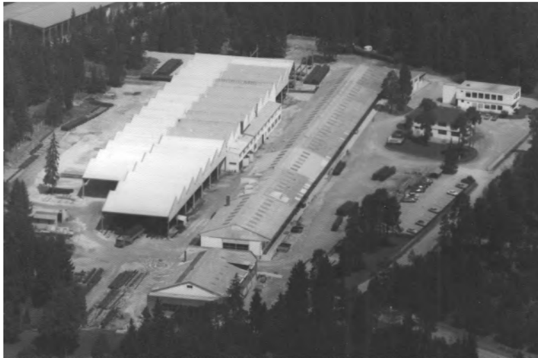
Abb. 13: FILIGRAN-Grundstück in Geretsried (aus S4-F3-M3)
