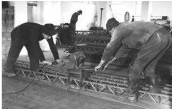
Abb. 6: Anrütteln der Betonfußleiste an den Fachwerkträger (aus S1-F2-M6)
