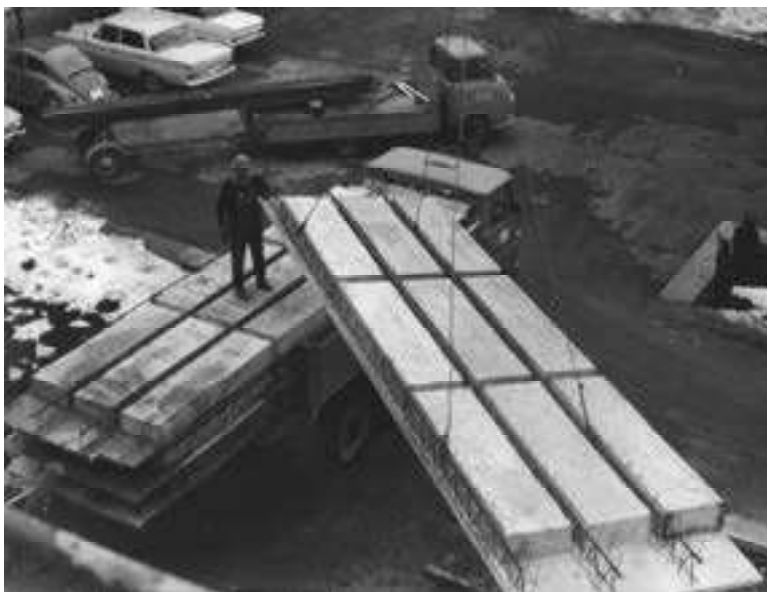
Abb. 50: Transport der FILIGRAN-Rippenelemente zur Baustelle (aus S4-F5-M2)
