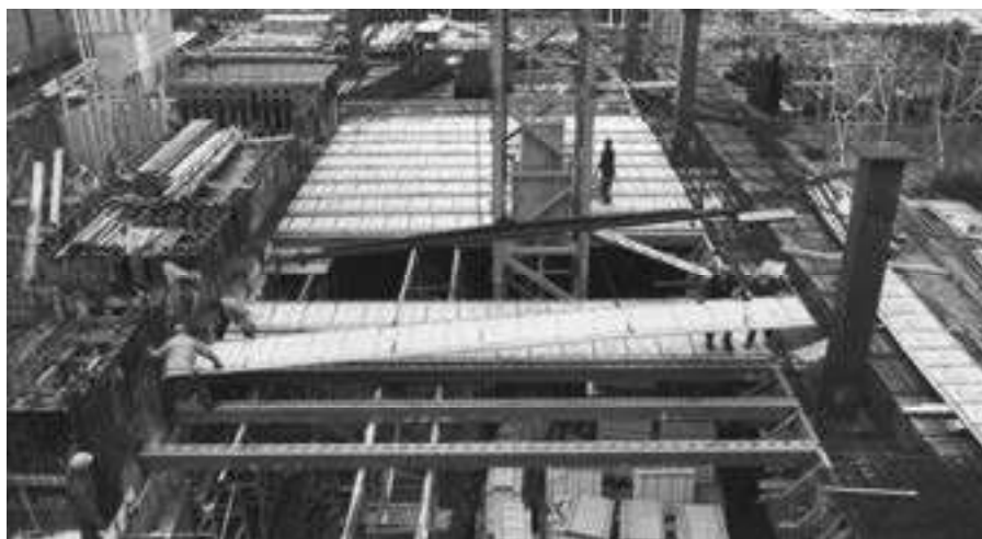
Abb. 48: Platzieren eines FILIGRAN-Elements (aus S4-F5-M2)
