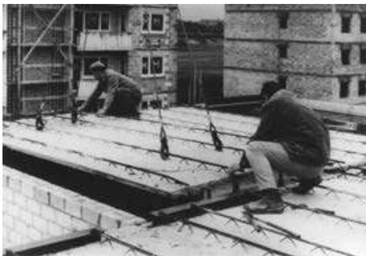
Abb. 44: FILIGRAN-Elementdecke (aus S1-F2-M11)
