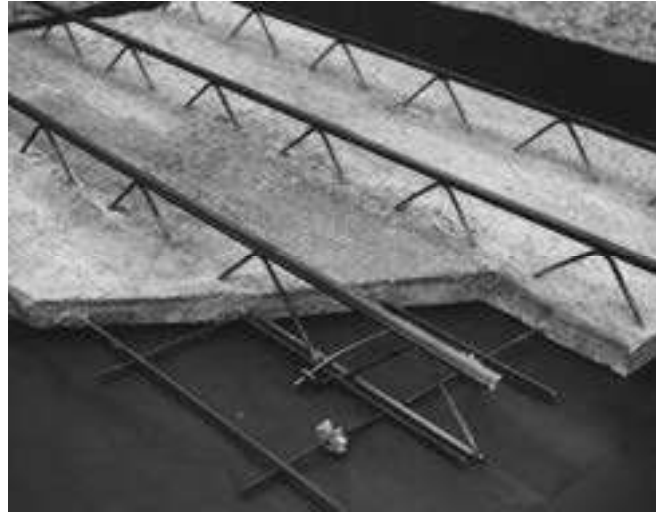
Abb. 31: FILIGRAN-Element mit SE-Trägern und unterer Biegezugbewehrung (aus S1-F2-M5)
